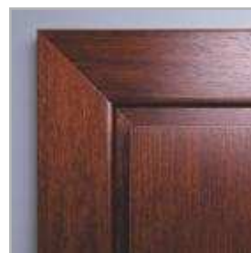
spojenie obložkových lišt pod uhlom 45°
